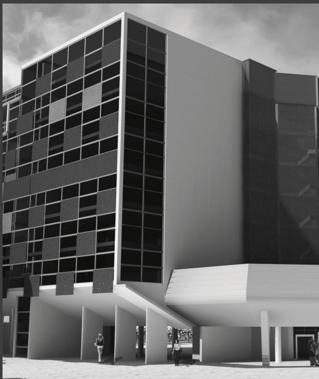
Edificio caposaldo centrale, angolo nord-ovest
